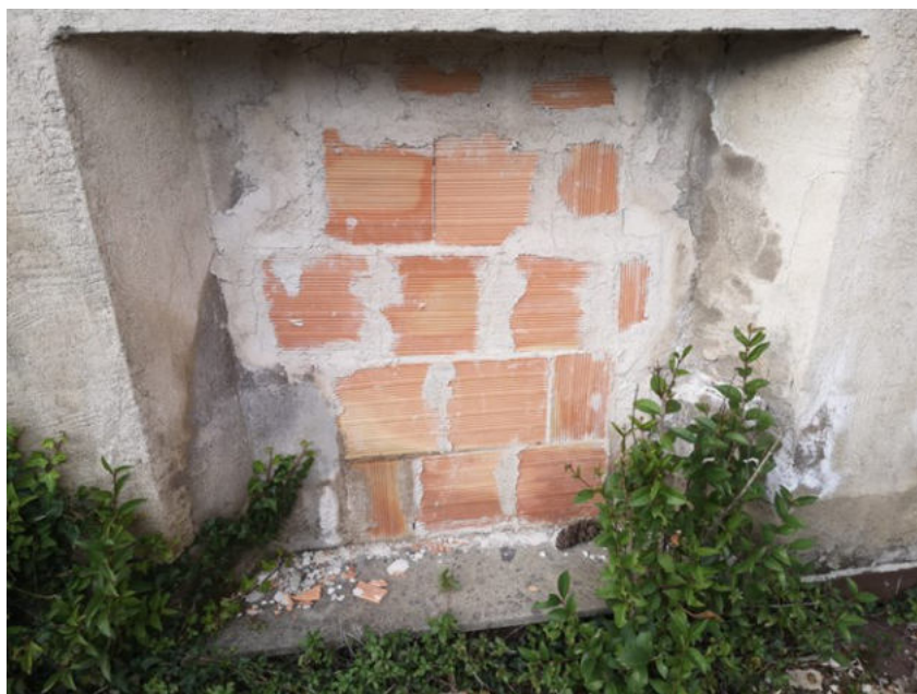
Foto 7: particolare chiusura finestra
